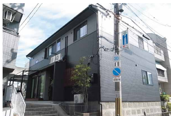
▲「コモンフルール」の外観
